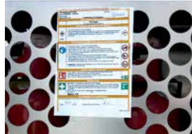
Gasflaschenlager (außen) mit Betriebsanweisung
