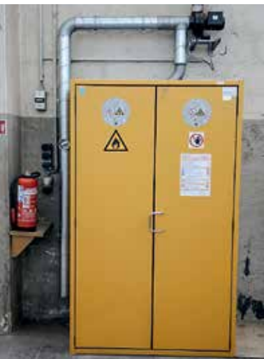
Sicherheitsschrank (DIN EN 14470-1), hier mit technischer Lüftung und selbsttätig schließenden Türen
