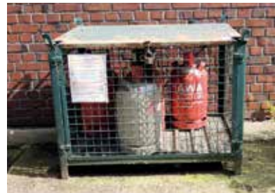
Gasflaschen (LPG) in verschlossener Gitterbox
