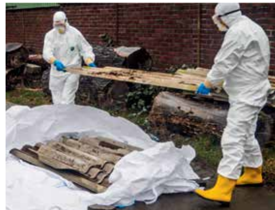
Beschädigte Asbestzementplatten bei Vollschutz zur Entsorgung in BigPacks verpackt
