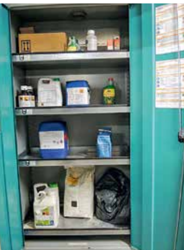
Sicherheitsschrank (DIN 12925-1), hier mit Anschluss an den belüfteten Außenbereich
