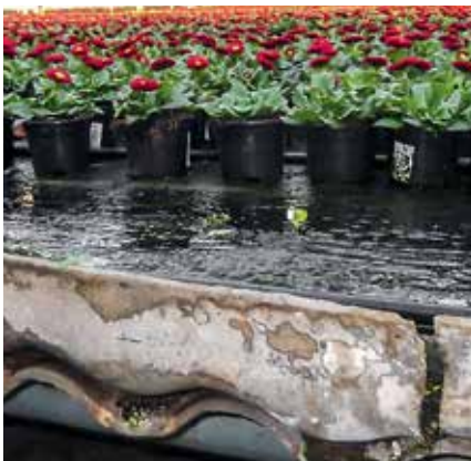
Beschädigte Asbestzementplatte
