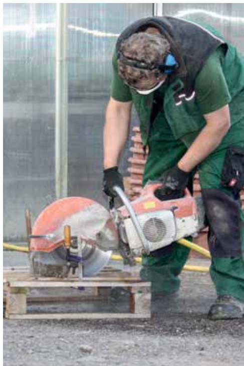
Nassschneiden von Betonwerksteinen
